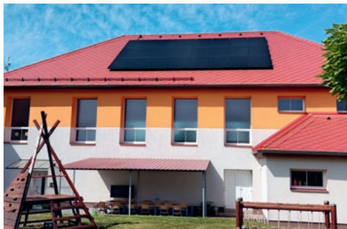
FVE na škole, foto: -rb-
